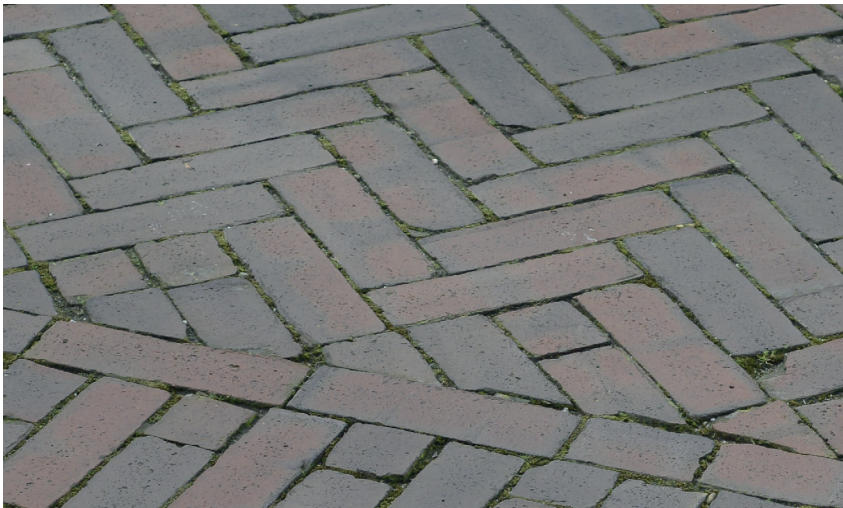
De scheiding tussen de rijbaan en de parkeerplaatsen bestaat uit een streklaag
