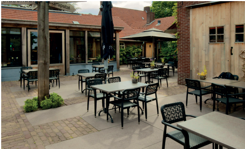
Voorbeeld van een combinatie van gebakken klinkers met hoogwaarde betontegels (Schellevis)
