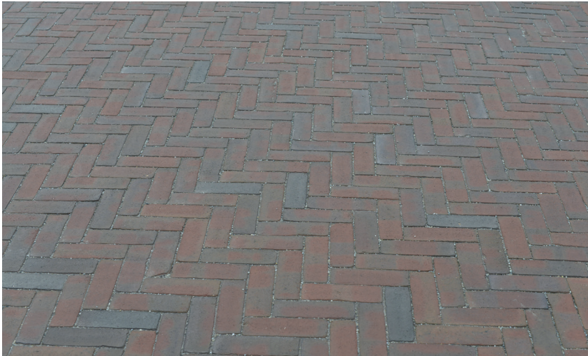
De basis voor de rijbaan bestaat uit gebakken klinkers in keperverband
