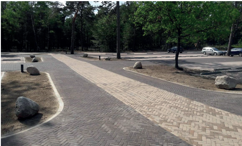
De begeleiding van de rijbaan en het voorkomen van parkeren in de berm wordt op plekken waar geen verhoogde band aanwezig is vormgegeven met zwerfkeien
