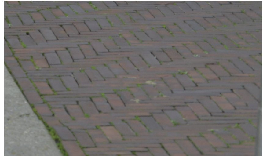
De parkeerplaatsen bestaan uit elleboogverband
