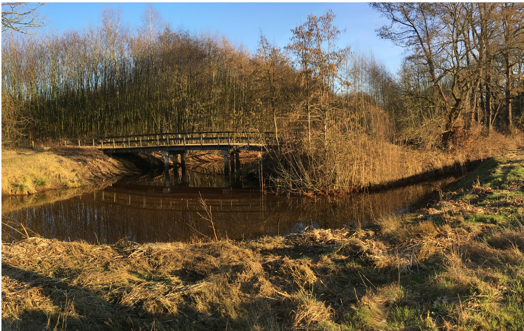
Samenkomst Bosbeek en Molen Aa met bestaande brug over de Bosbeek
